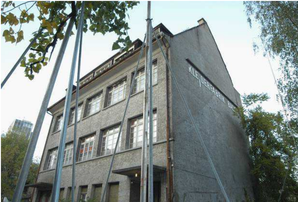
Die Kleiderfabrik Baden 2007 kurz vor dem Abriss.
