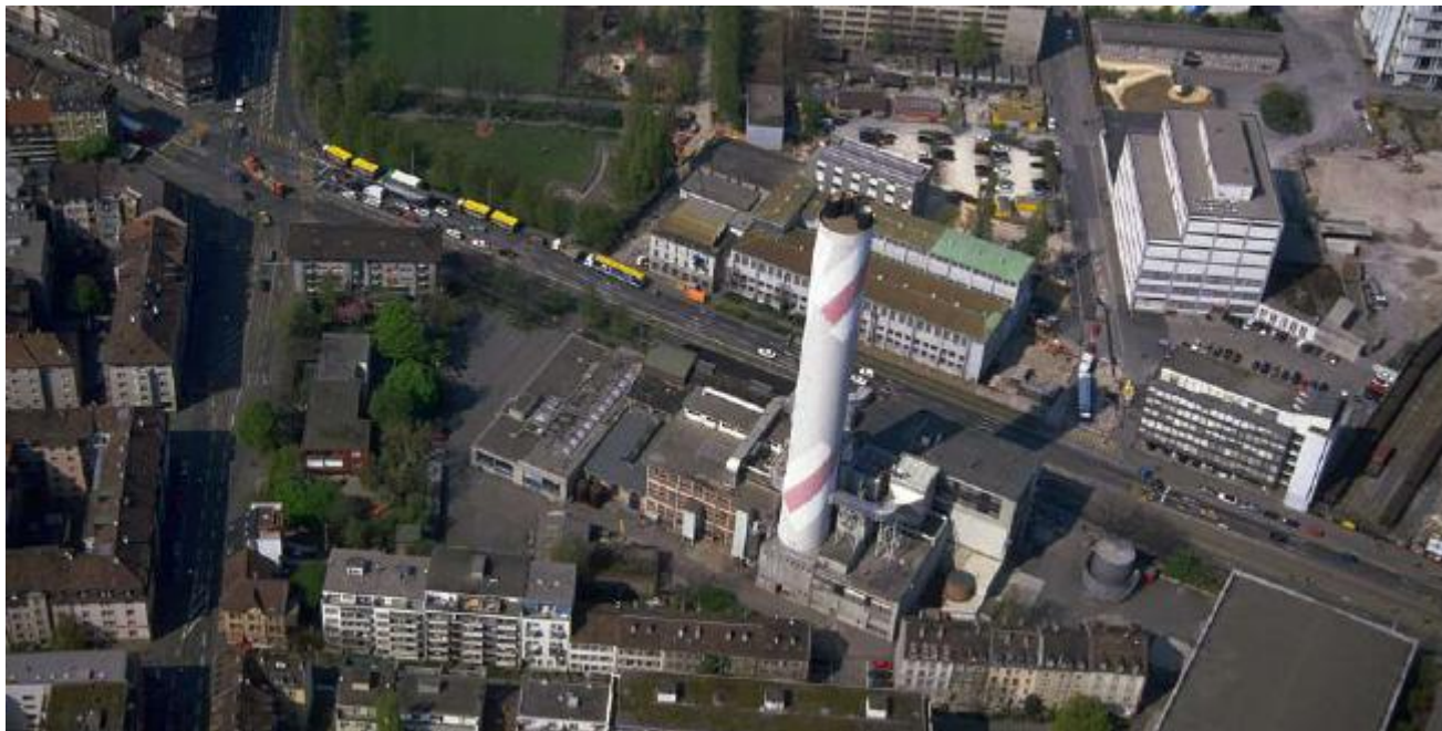
Basler Symbol der Energiewende. Der Umstieg auf Fernwärme mit einem gegenüber Gas höchst bedenklichen Effizienzgrad wird als Lösung der Probleme propagiert. Foto Mathias Leemann
