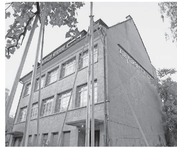
Die Kleiderfabrik Baden 2007 kurz vor dem Abriss. ARCHIV BT
