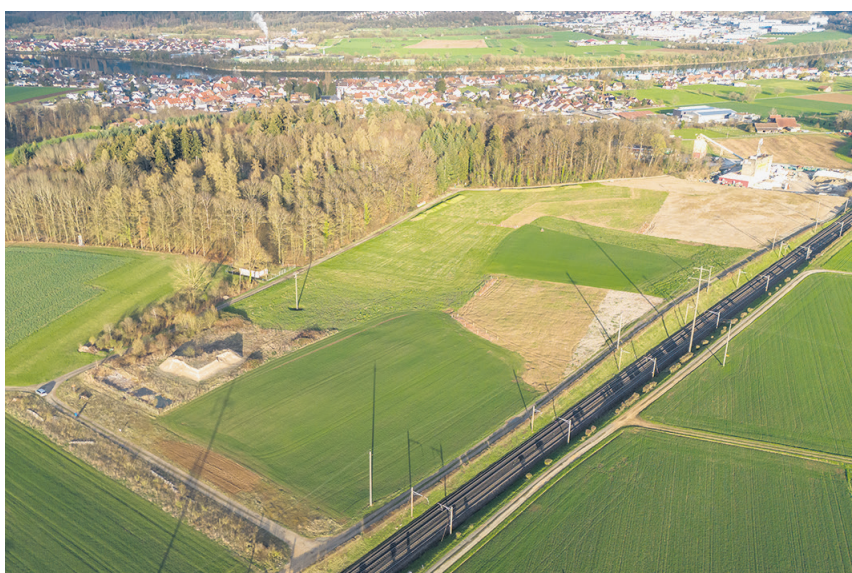
Auf diesem Gelände in Zeiningen läuft das Projekt.
